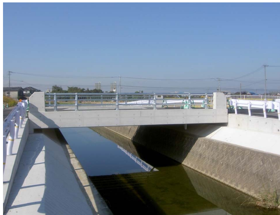
完成(After) 側面
