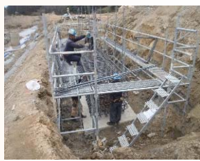
桁下面型枠設置状況
