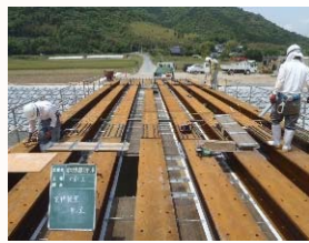
桁下面型枠設置状況
