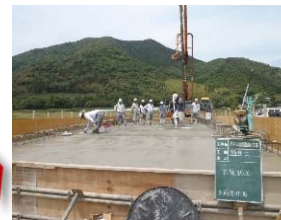
橋体Co打設状況
