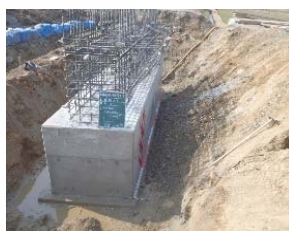
桁上面鉄筋組立状況
