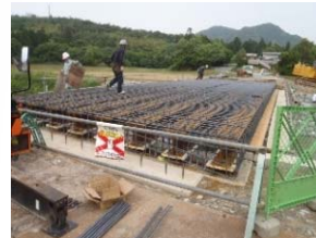
桁上面鉄筋組立状況
