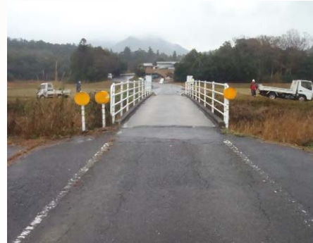
施工前(Before) 正面
