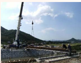
H鋼桁架設状況
