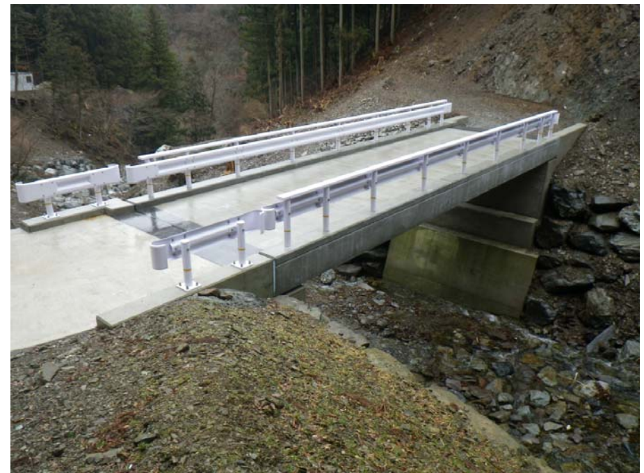
完成(After) 側面
