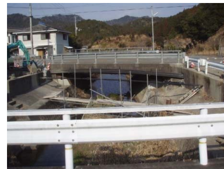
施工前(Before) 側面
