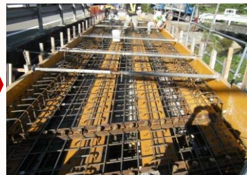
鉄筋組及び側面型枠組
