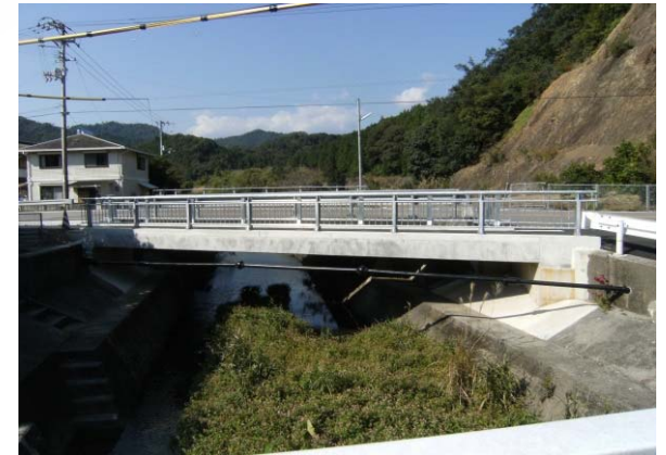
完成(After) 正面
