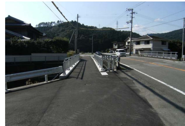
完成(After) 側面
