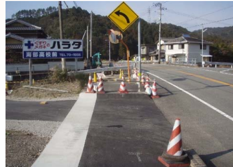
施工前(Before) 正面
