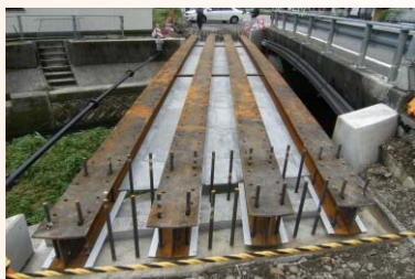
桁架設及び下面埋設型枠 (GRC製)
