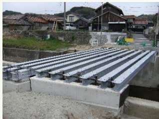
H鋼桁架設状況
