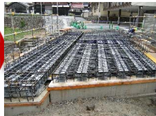
桁上面鉄筋組立状況
