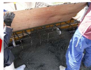
橋体Co打設状況
