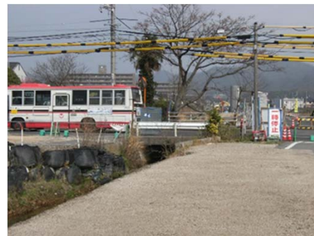
施工前(Before) 側面
