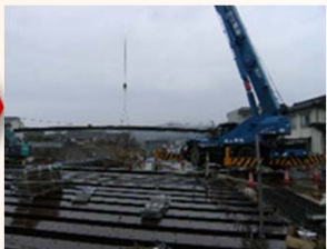
H鋼桁架設状況
