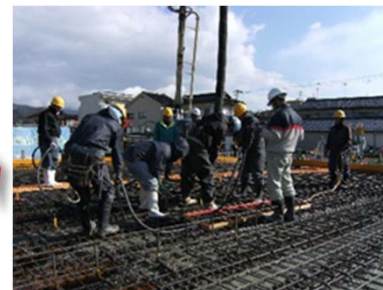
橋体Co打設状況
