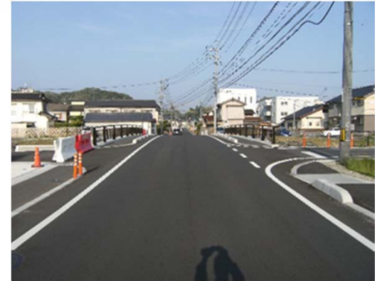
完成(After) 正面
