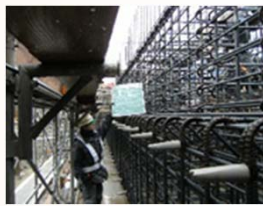
橋台鉄筋組立状況
