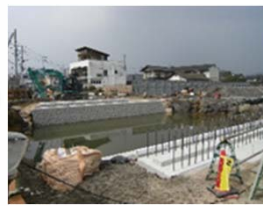
桁上面鉄筋組立状況
