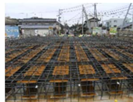
桁上面鉄筋組立状況
