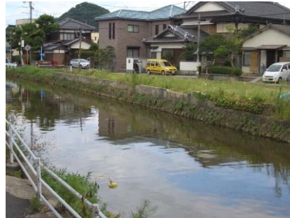
施工前(Before) 側面
