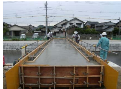
橋体Co打設状況
