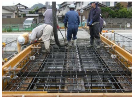
桁下面型枠設置状況
