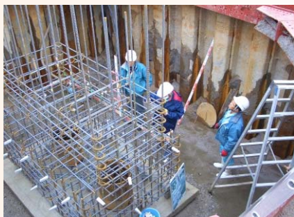
橋台鉄筋組立状況
