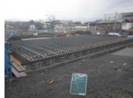
桁上面鉄筋組立完了
