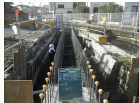
橋台鉄筋組立完了
