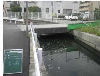
施工前(Before) 側面
