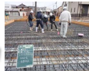
橋体Co打設状況
