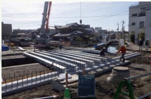
H鋼桁架設状況
