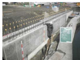
橋台Co完了
