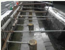
基礎杭の打設完了
