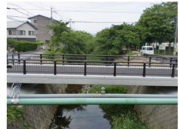
完成(After) 側面
