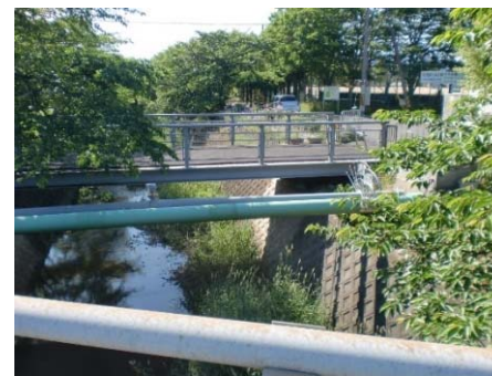
施工前(Before) 側面
