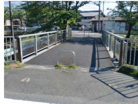
施工前(Before) 正面
