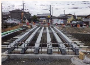
H鋼桁架設状況
