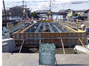
桁上面鉄筋組立状況
