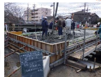
橋体Co打設状況
