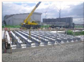
H鋼桁架設状況
