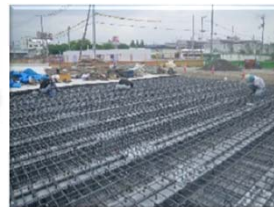
桁上面鉄筋組立状況
