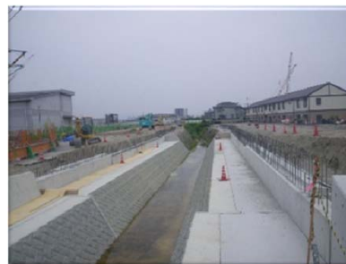
施工前(Before) 側面
