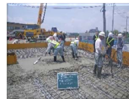
橋体Co打設状況
