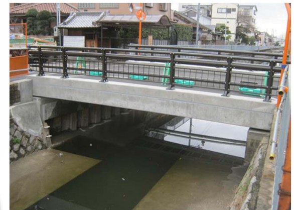
完成(After) 側面
