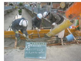
橋体Co打設状況
