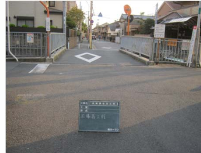
施工前(Before) 正面
