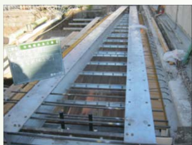
H鋼桁架設状況
