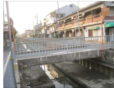
施工前(Before) 側面
