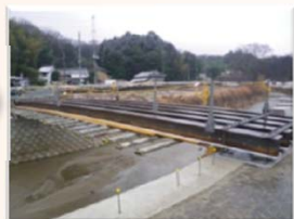
H鋼桁架設状況
