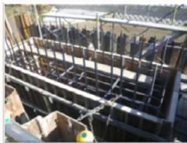
橋台鉄筋組立状況
