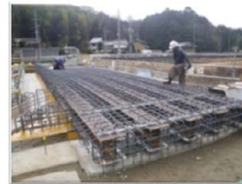
桁上面鉄筋組立状況
