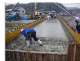
橋体Co打設状況
