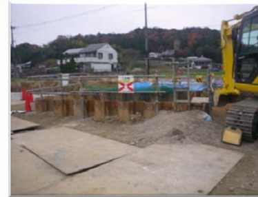
施工前(Before) 正面
