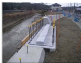
橋台Co打設状況
