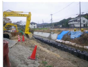
施工前(Before) 側面
