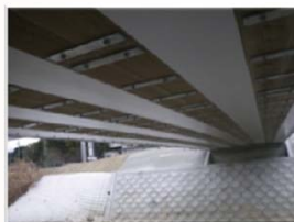
桁下面型枠設置状況
