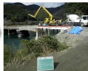
橋体Co打設状況
