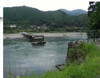
施工前(Before) 側面
