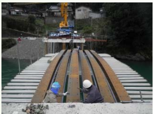
H鋼桁架設状況
