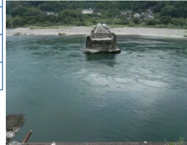
施工前(Before) 正面
