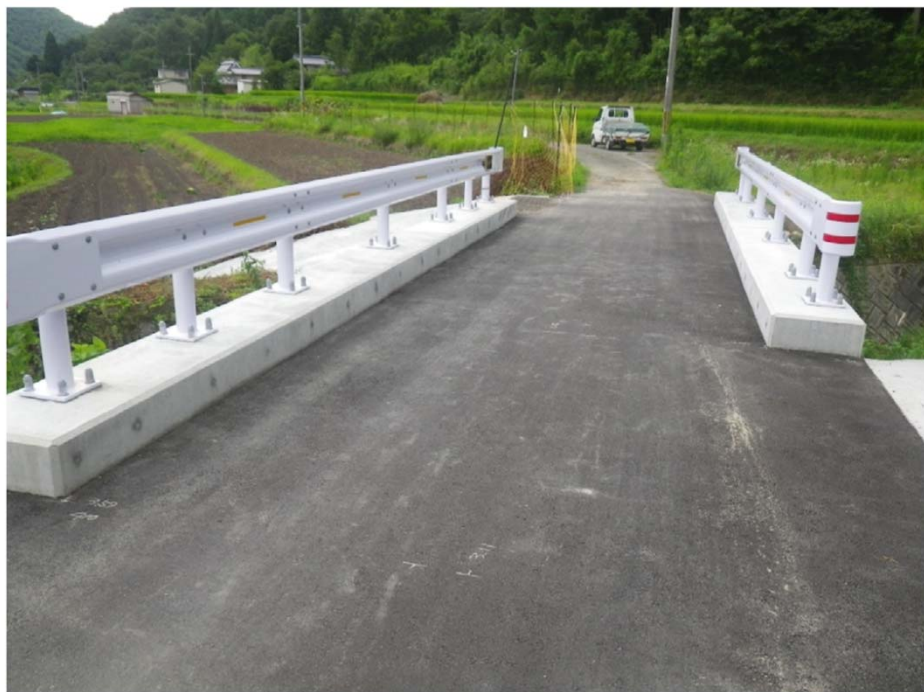
完成(After) 正面
