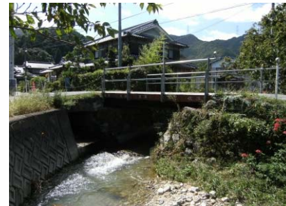
施工前(Before) 側面
