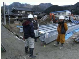
H鋼桁架設状況
