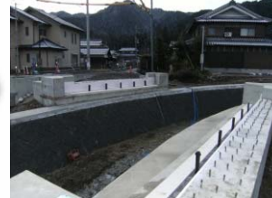
橋体Co打設状況
