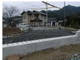
桁上面鉄筋組立状況
