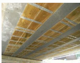
桁下面型枠設置状況
