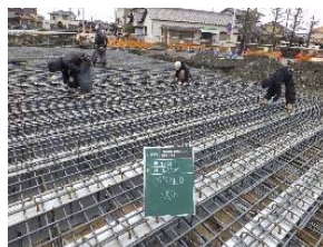
桁上面鉄筋組立状況
