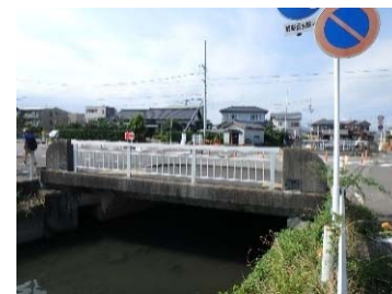
施工前(Before) 側面
