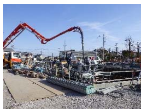
桁上面鉄筋組立状況
