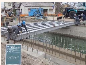
H鋼桁架設状況
