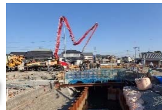
橋体Co打設状況
