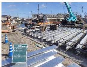
桁下面型枠設置状況
