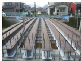
桁下面型枠設置状況
