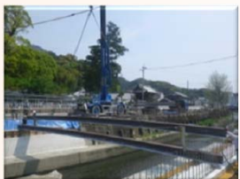
H鋼桁架設状況
