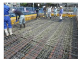
橋体Co打設状況
