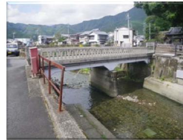
施工前(Before) 側面
