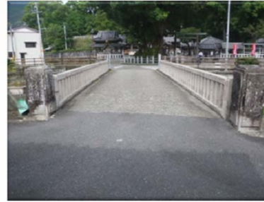
施工前(Before) 正面
