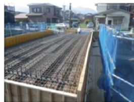
桁上面鉄筋組立状況
