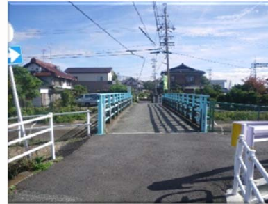
施工前(Before) 正面
