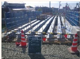
H鋼桁架設状況
