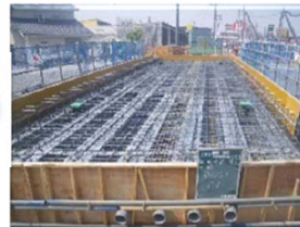
桁上面鉄筋組立状況
