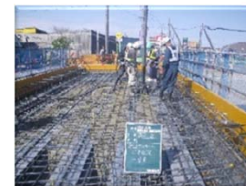
橋体Co打設状況
