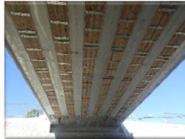
桁下面型枠設置状況
