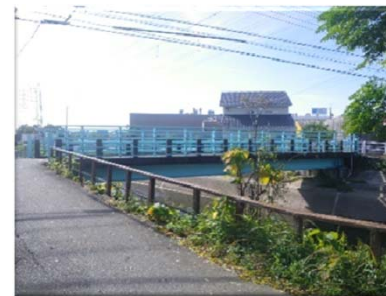
施工前(Before) 側面
