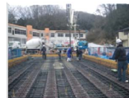
橋体Co打設状況
