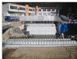
橋台Co打設状況
