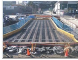
桁上面鉄筋組立状況
