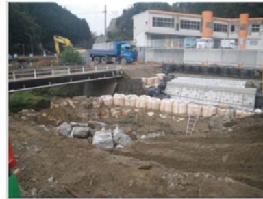
施工前(Before) 正面
