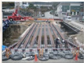
H鋼桁架設状況
