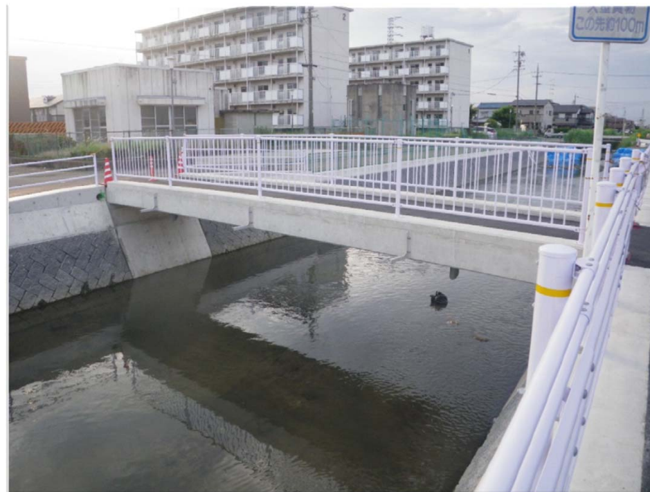
完成(After) 側面
