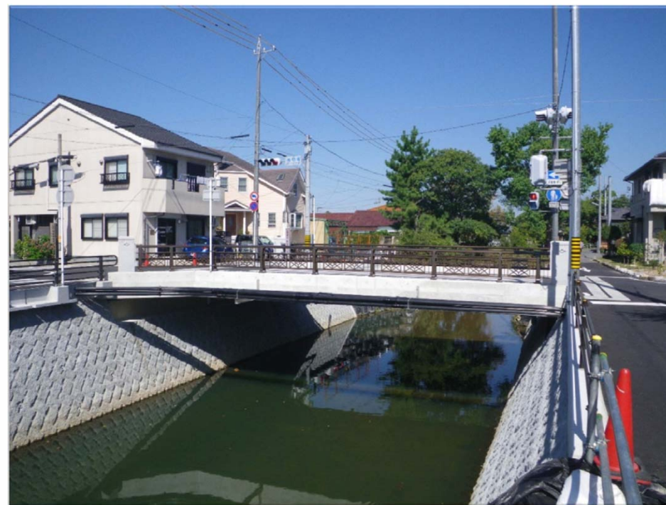
完成(After) 側面
