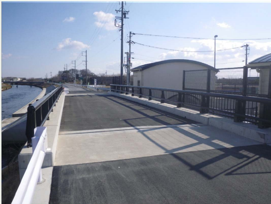
完成(After) 正面
