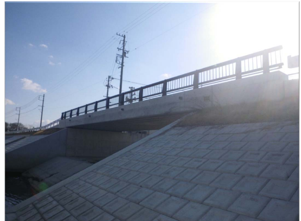
完成(After) 側面
