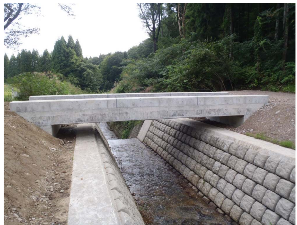
完成(After) 側面
