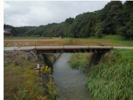
施工前(Before) 正面
