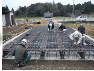
桁上面鉄筋組立状況
