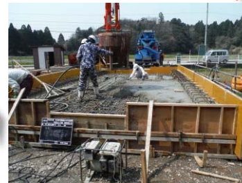
橋体Co打設状況
