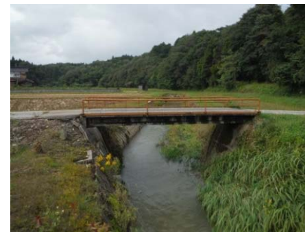
施工前(Before) 側面
