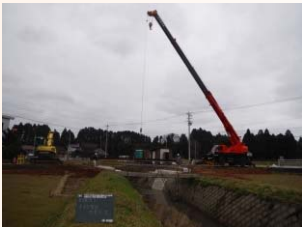
H鋼桁架設状況
