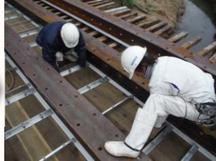
桁下面型枠設置状況
