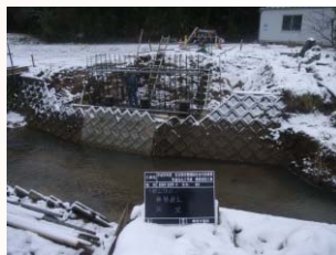
桁下面型枠設置状況
