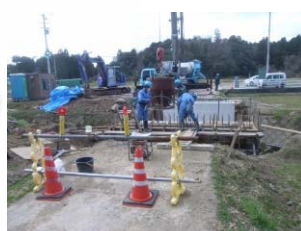
桁上面鉄筋組立状況
