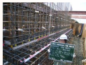
桁下面型枠設置状況
