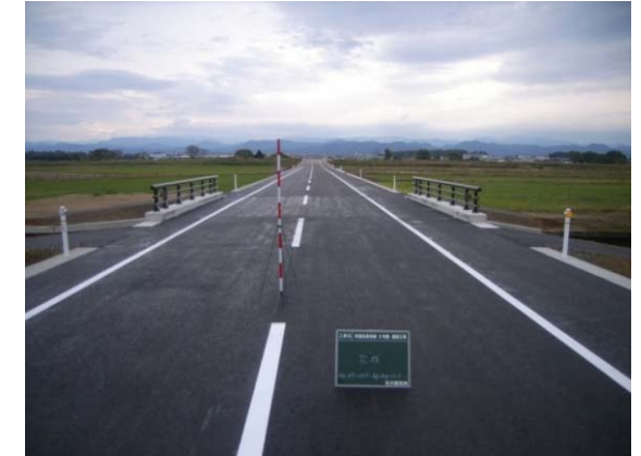
完成(After) 正面
