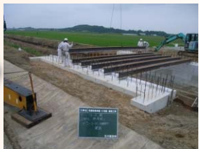
H鋼桁架設状況
