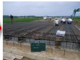
桁上面鉄筋組立状況
