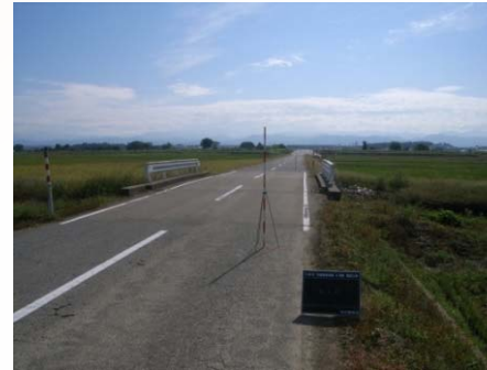
施工前(Before) 正面
