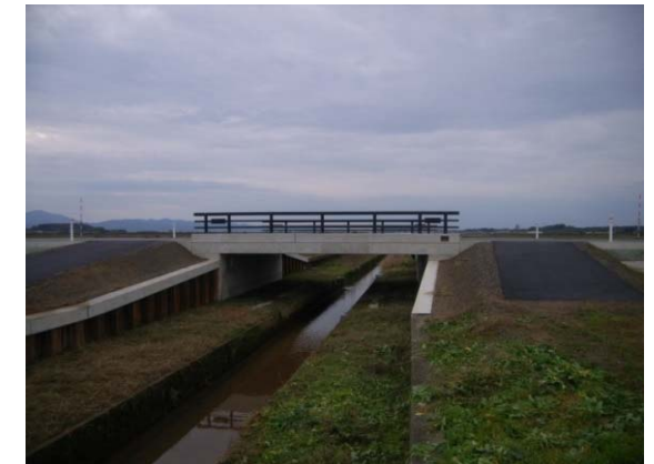
完成(After) 側面
