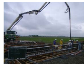
桁上面鉄筋組立状況
