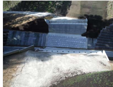
施工前(Before) 正面
