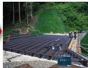
桁上面鉄筋組立状況
