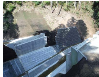
施工前(Before) 側面
