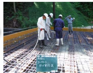
橋体Co打設状況
