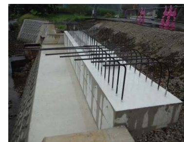
施工前(Before) 側面
