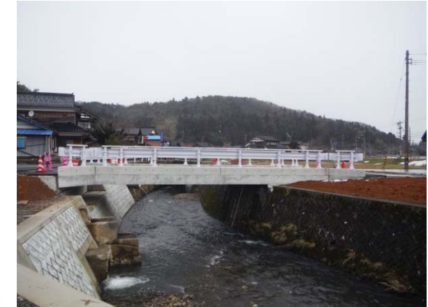
完成(After) 側面
