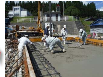
橋体Co打設状況
