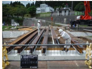
桁上面鉄筋組立状況
