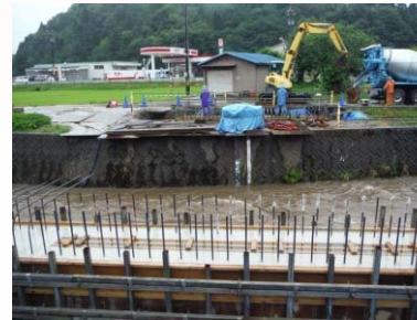
施工前(Before) 正面
