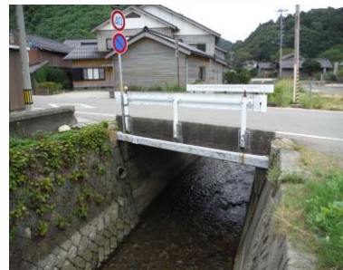
施工前(Before) 側面
