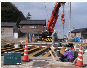
H鋼桁架設状況
