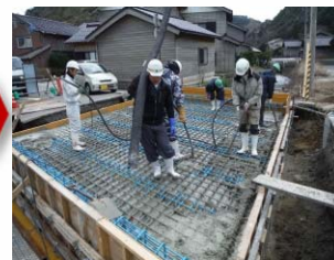
橋体Co打設状況
