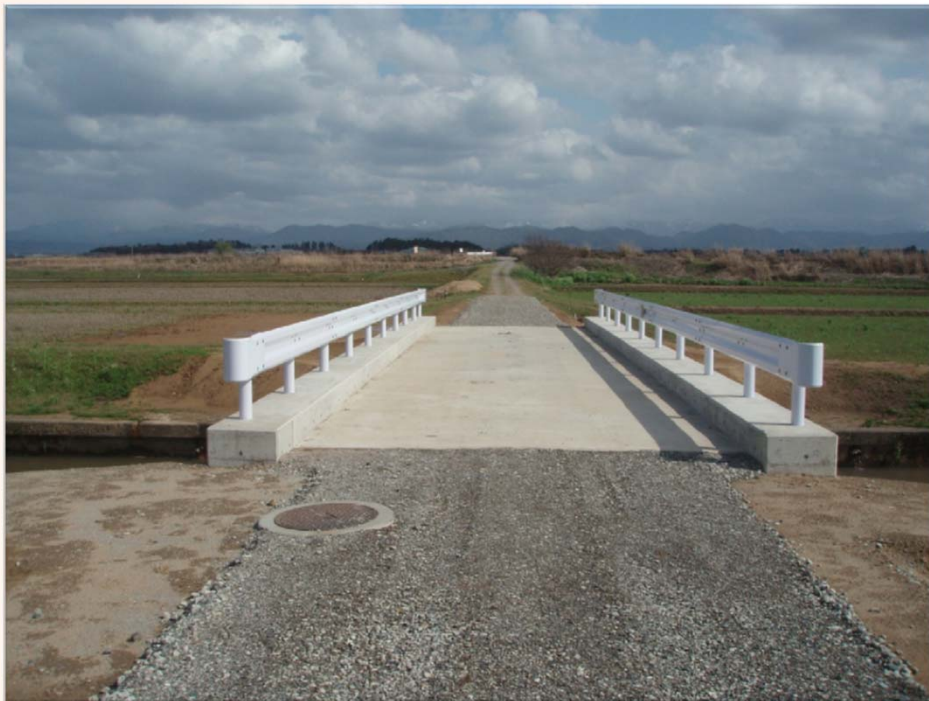
完成(After) 正面
