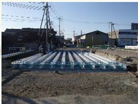
H鋼桁架設完了
