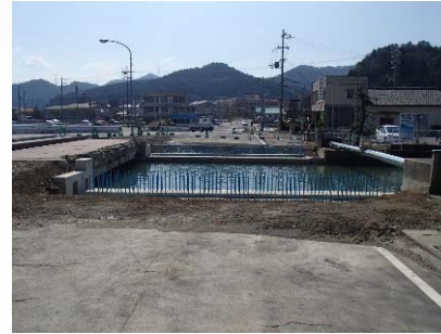
施工前(Before) 正面
