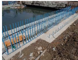
桁上面鉄筋組立完了
