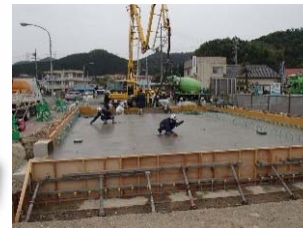
橋体Co打設状況
