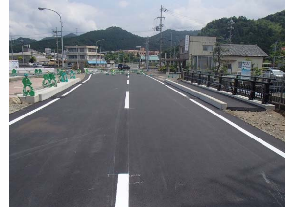
完成(After) 正面
