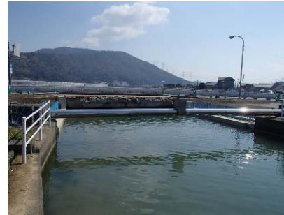
施工前(Before) 側面
