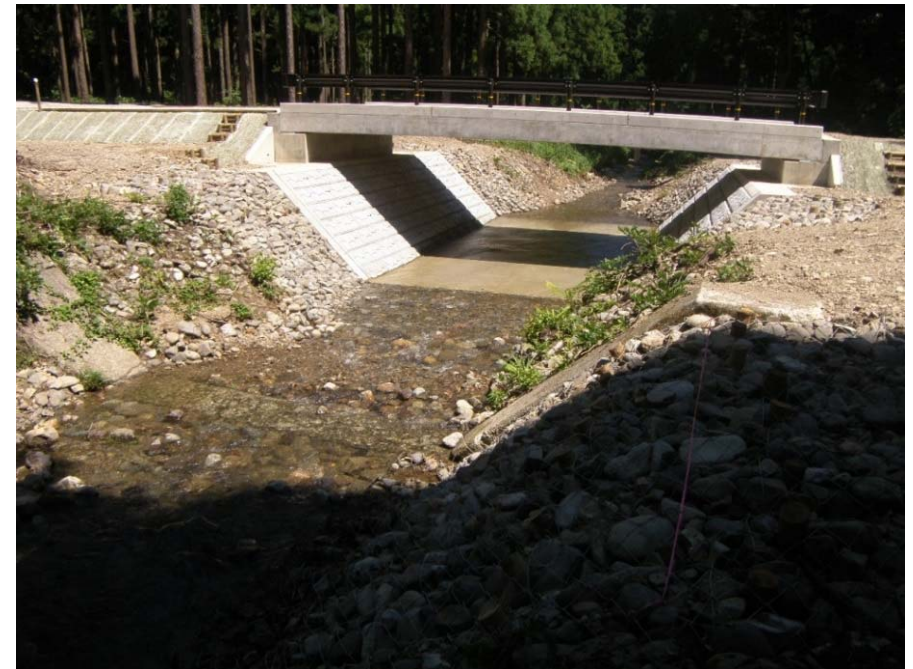
完成(After) 側面
