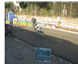
橋体Co打設状況
