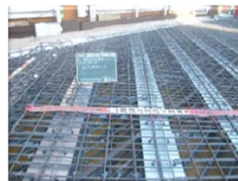
桁上面鉄筋組立状況
