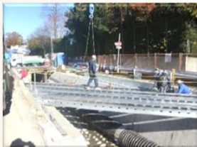
H鋼桁架設状況
