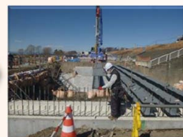
H鋼桁架設状況
