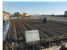
桁上面鉄筋組立状況
