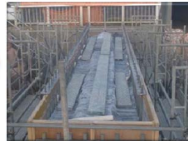
桁上面鉄筋組立状況
