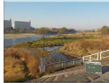
施工前(Before) 正面
