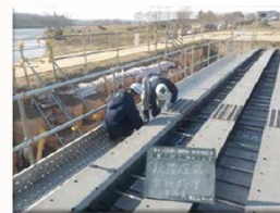
桁下面型枠設置状況
