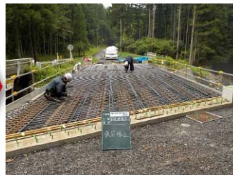
桁上面鉄筋組立状況
