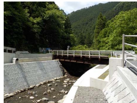
施工前(Before) 側面
