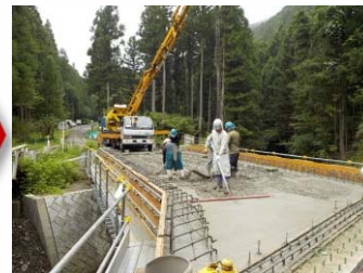
橋体Co打設状況
