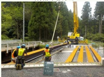
H鋼桁架設状況
