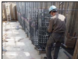
桁下面型枠設置状況
