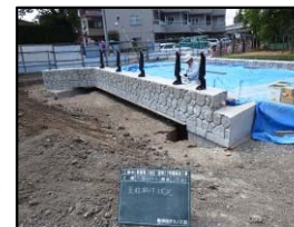
橋体Co打設状況
