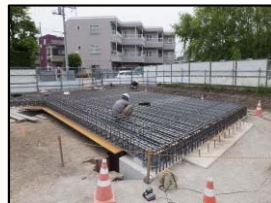
桁下面型枠設置状況
