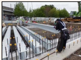
H鋼桁架設状況
