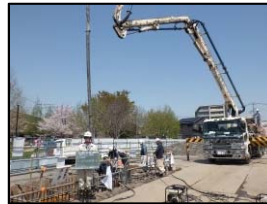
桁上面鉄筋組立状況
