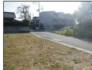
施工前(Before) 側面
