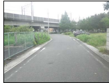
施工前(Before) 正面
