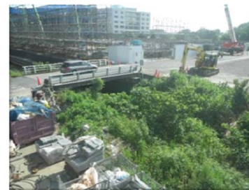
施工前(Before) 側面
