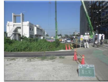
施工前(Before) 正面
