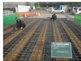
桁上面鉄筋組立状況
