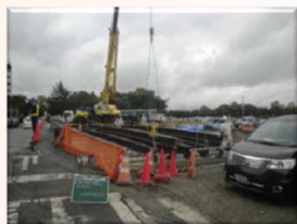
H鋼桁架設状況
