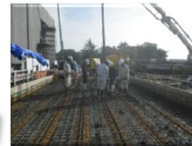
橋体Co打設状況
