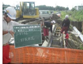
桁上面鉄筋組立状況
