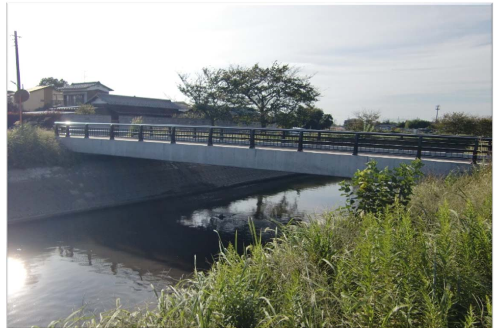
完成(After) 側面
