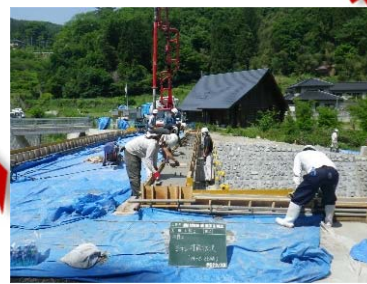
地覆Co打設状況
