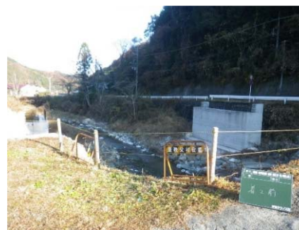
施工前(Before) 側面
