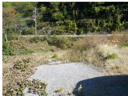
施工前(Before) 正面
