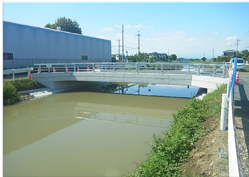
完成(After) 側面
