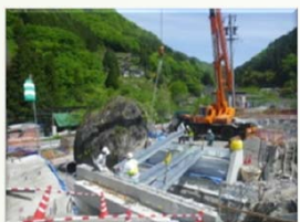
H鋼桁架設状況
