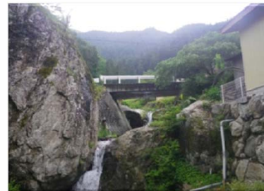
施工前(Before) 側面
