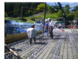
橋体Co打設状況
