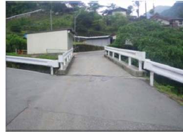
施工前(Before) 正面
