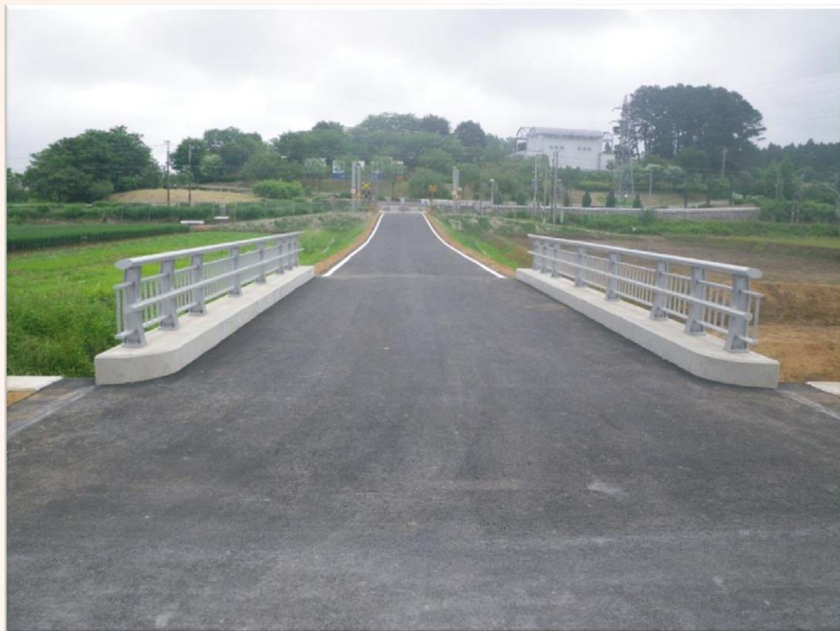
完成(After) 正面
