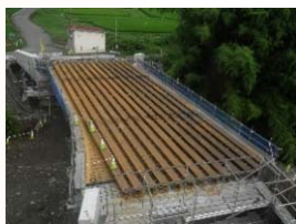
桁下面型枠設置状況
