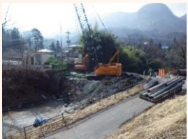
基礎杭の打設状況
