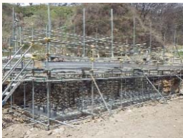
橋台鉄筋組立状況
