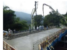
橋体Co打設状況
