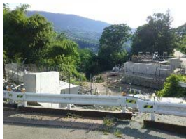
橋台Co打設状況
