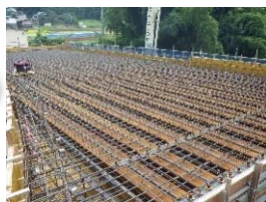
桁上面鉄筋組立状況
