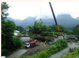
H鋼桁架設状況
