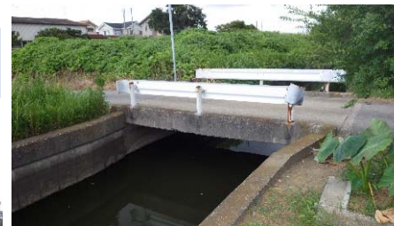
施工前(Before) 側面
