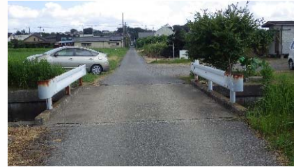
施工前(Before) 正面
