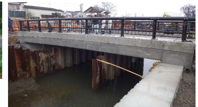
完成(After) 側面
