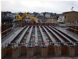
H鋼桁架設状況
