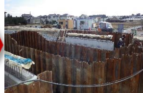
橋台Co打設状況
