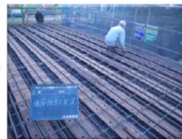
桁上面鉄筋組立状況
