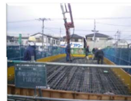
橋体Co打設状況
