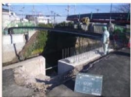
H鋼桁架設状況
