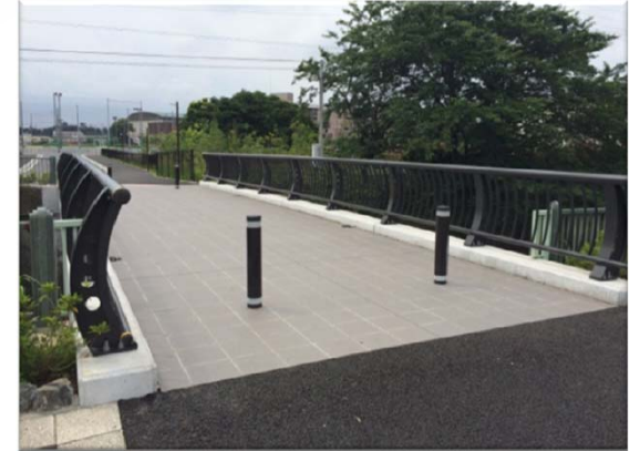
完成(After) 正面
