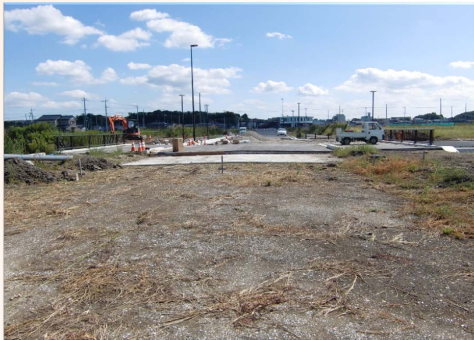
完成(After) 正面
