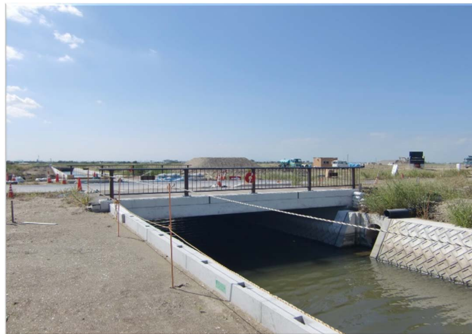
完成(After) 側面
