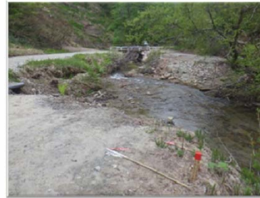
施工前(Before) 側面
