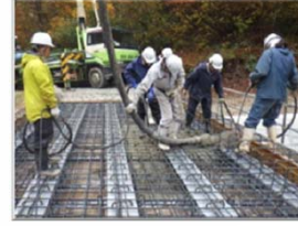
橋体Co打設状況
