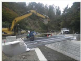
H鋼桁架設状況
