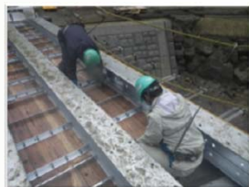
桁下面型枠設置状況
