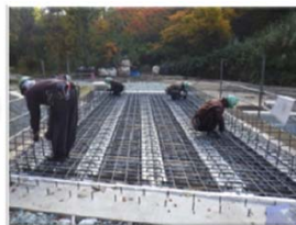
桁上面鉄筋組立状況
