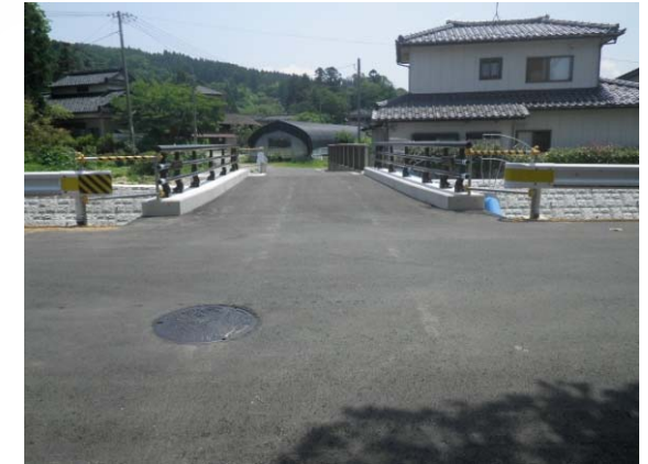
完成(After) 正面
