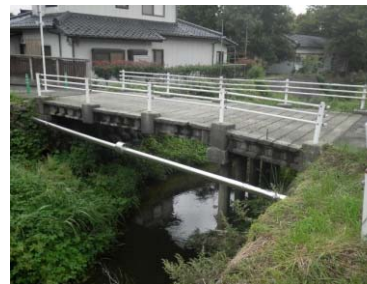
施工前(Before) 側面
