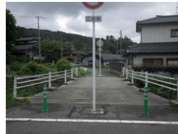
施工前(Before) 正面
