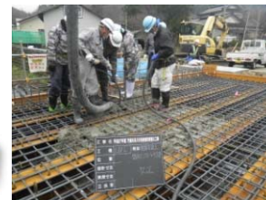
橋体Co打設状況
