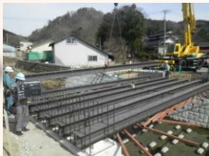
H鋼桁架設状況
