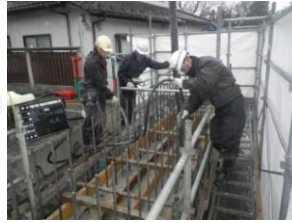
桁上面鉄筋組立状況
