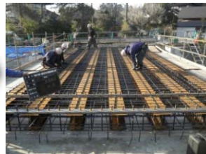
桁上面鉄筋組立状況
