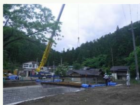
H鋼桁架設状況
