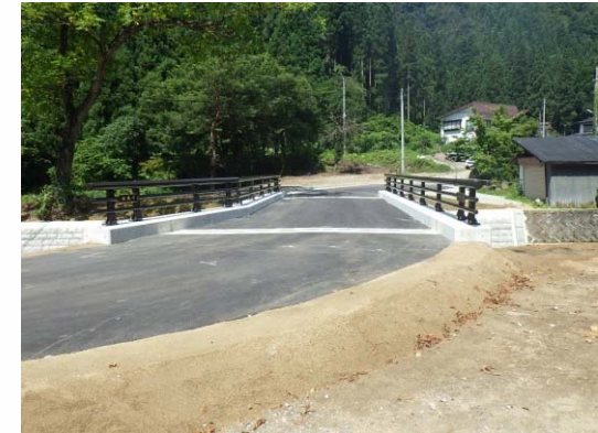
完成(After) 正面
