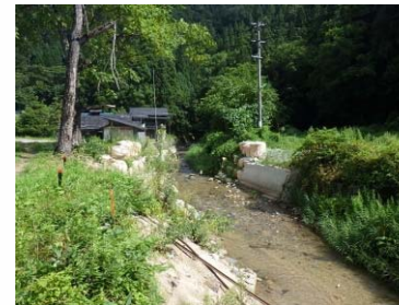
施工前(Before) 側面
