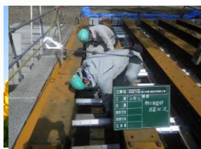
桁下面型枠設置状況
