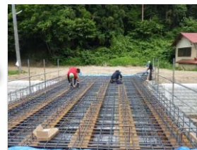
桁上面鉄筋組立状況
