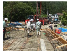
橋体Co打設状況
