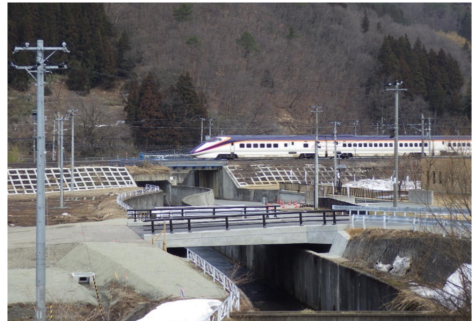
完成(After) 側面
